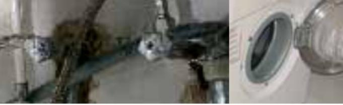
Die Fließregel besagt, dass „edlere“ Metalle, z. B. Kupfer, nicht vor „unedleren“, z. B. Stahl, verwendet werden dürfen, da diese das nachfolgende unedlere Metall lösen. Dies führt sowohl zu Korrosion im Rohrleitungssystem, aber auch zu erhöhter Schadstoffbelastung des Trinkwassers. Die Fließregel betrifft nicht nur Rohrleitungen, sondern alle verwendeten Installationsteile.
